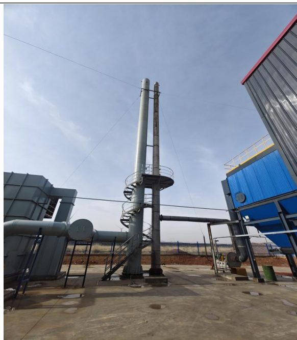
RTO 及残液焚烧炉排气筒
